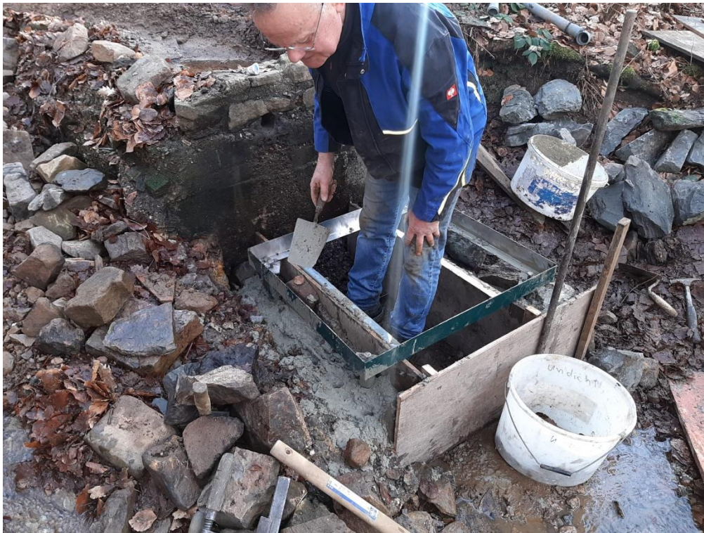
Heinz Köster setzt die Fundamente
