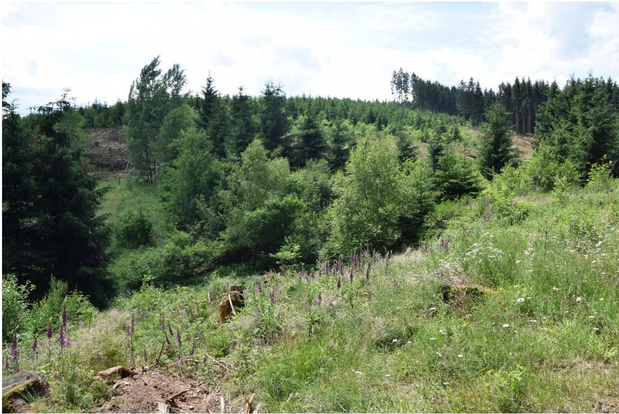
Zugewachsener Damm des Maasmicker Stauteichs
