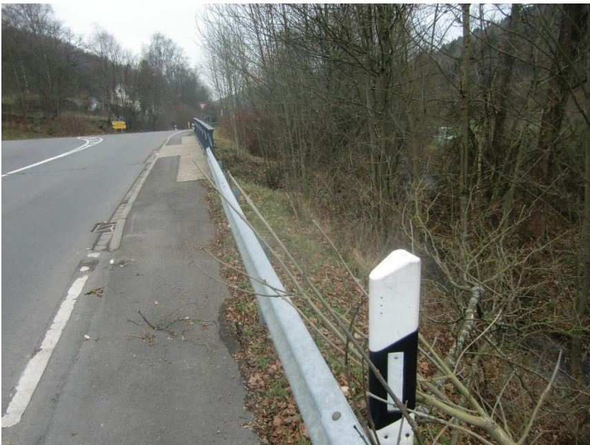
Unterhalb der Brücke in Richtung Neuenkleusheim endet der tiefe Stollen
