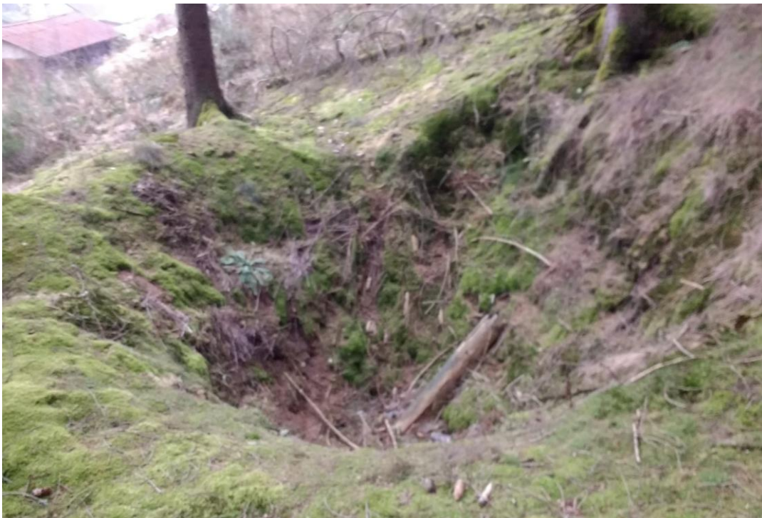
Eingefallenes Lichtloch des tiefen Stollens
