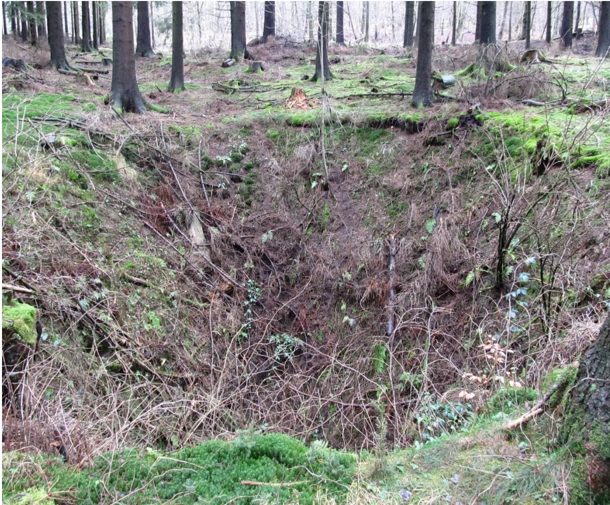
So sieht der Kunstschacht heute aus. Ca 25 m tiefer befindet sich die Radstube.
