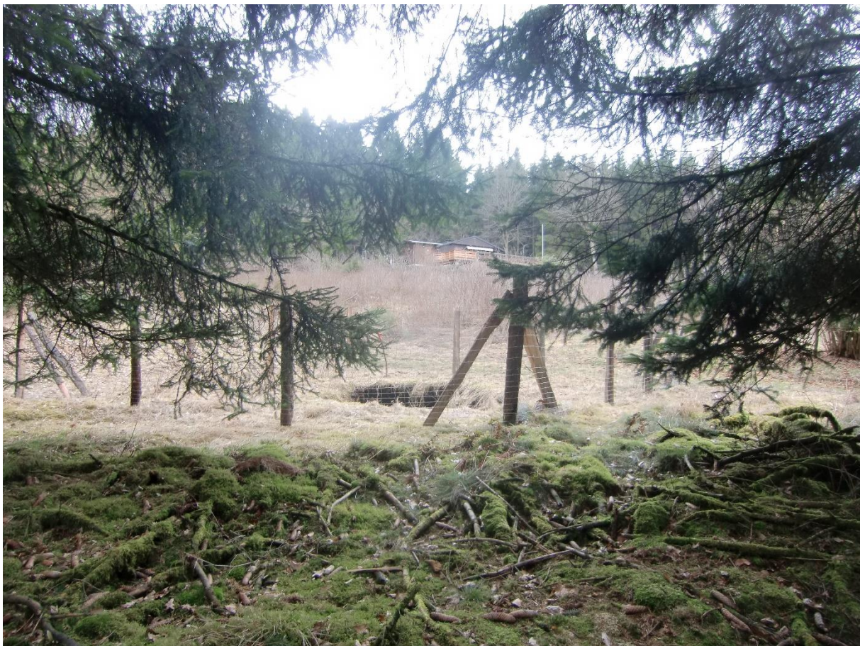
Tagesbruch unterhalb der SGV-Hütte in der Rhonard
