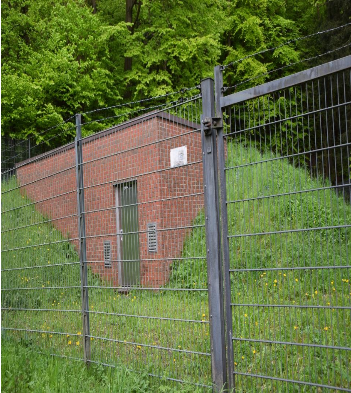
Eingang zum Wasserbehälter
