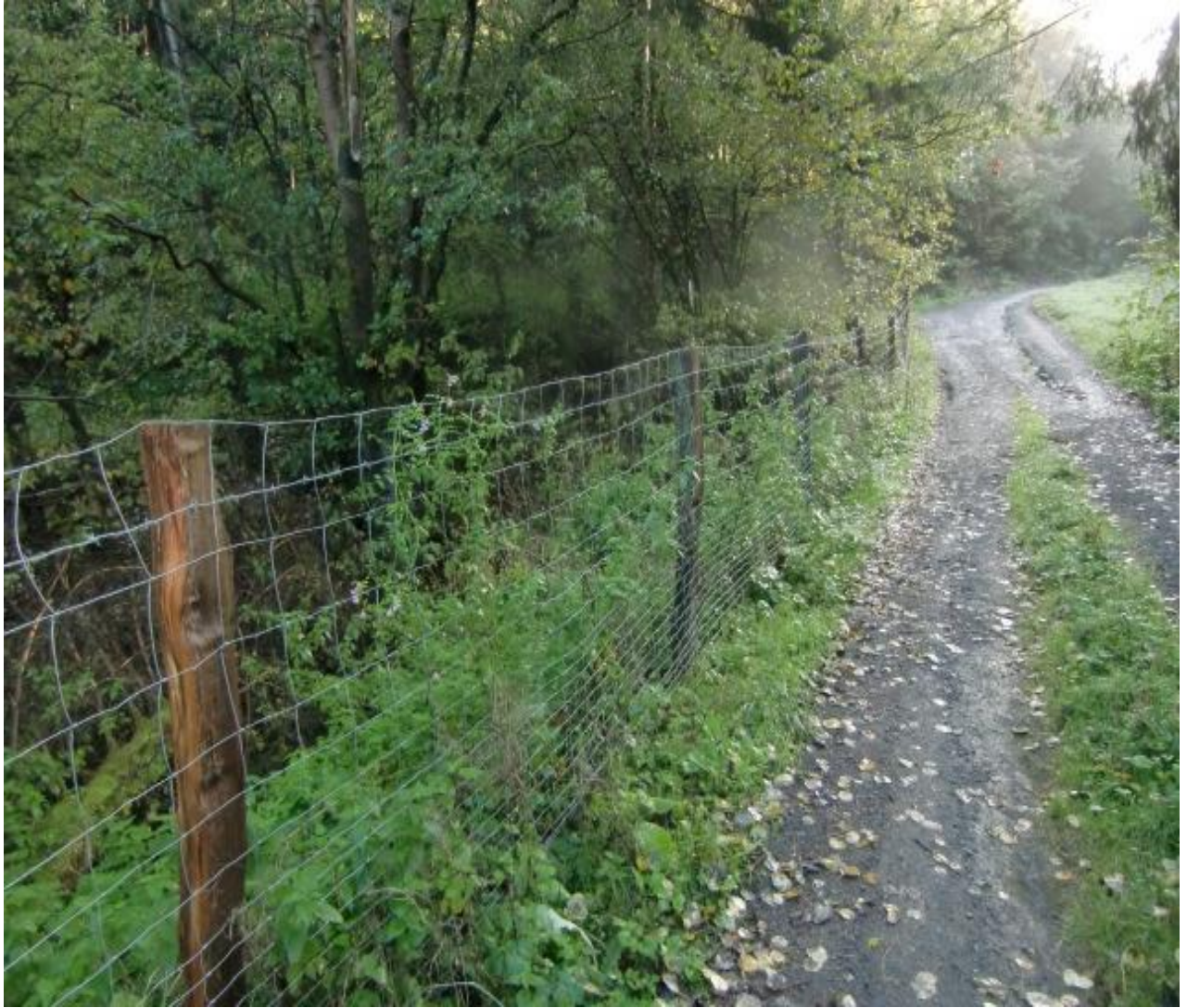
Abgesicherter ehemaliger Stolleneingang Liborius
