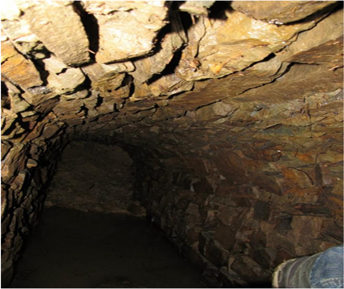
Gemauerter Wasserzulauf zur Radstube
