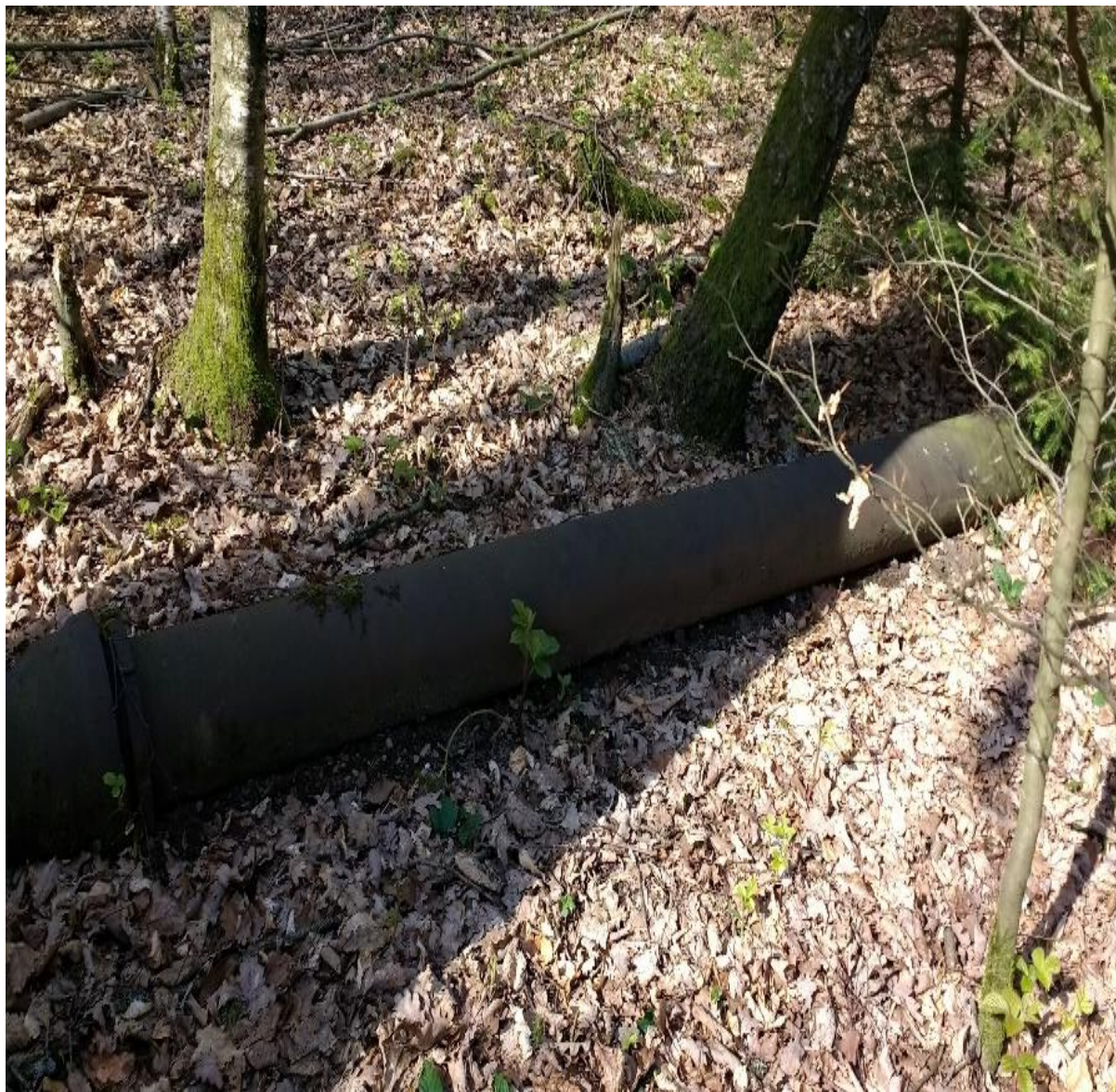
Alte Wasserleitung in der Rhonard
