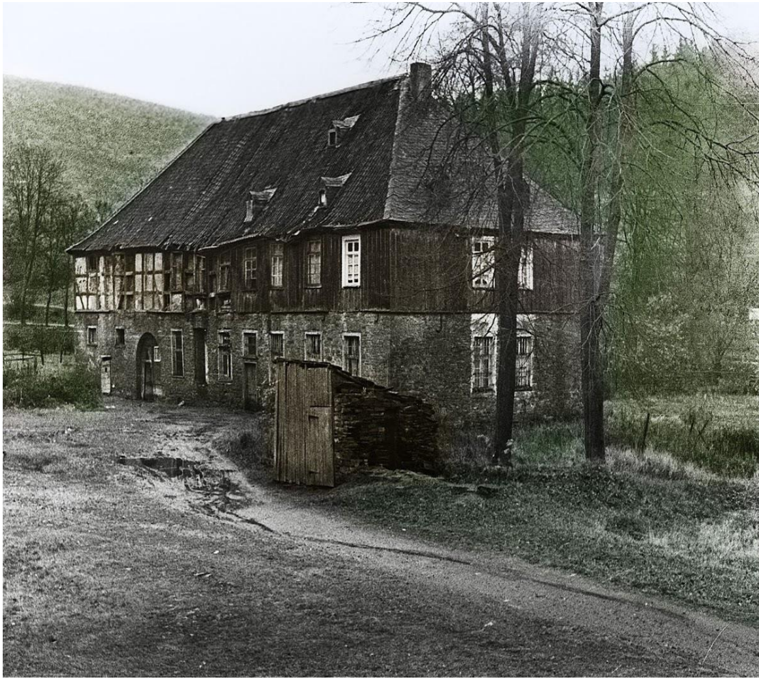
Das ehemalige Verwaltungsgebäude der Stachelauer Hütte, kurz vor dem Abriss. Mit den Steinen erneuerte man in Olpe den Hexen-und Engelsturm.
