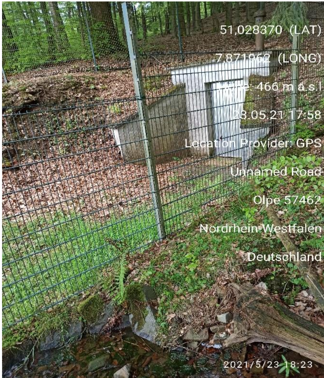
Stolleneingang am Grubenweg
