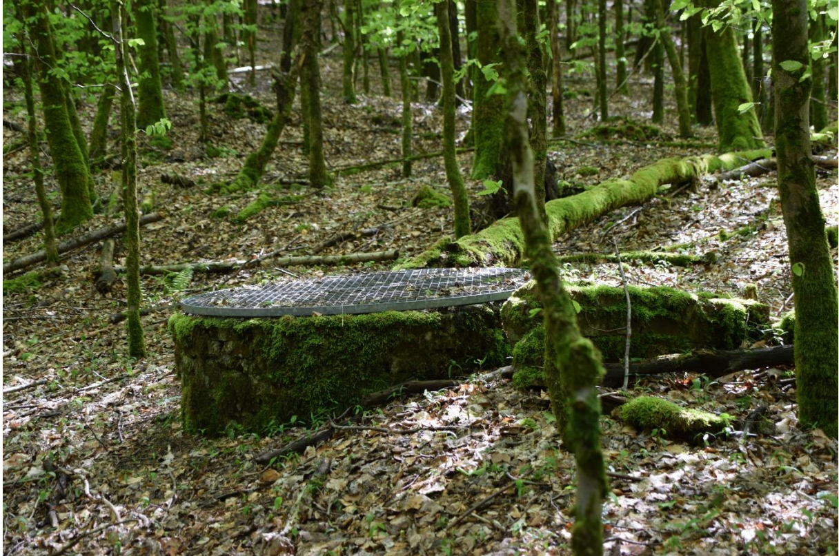
Brunnen oberhalb Stollen
