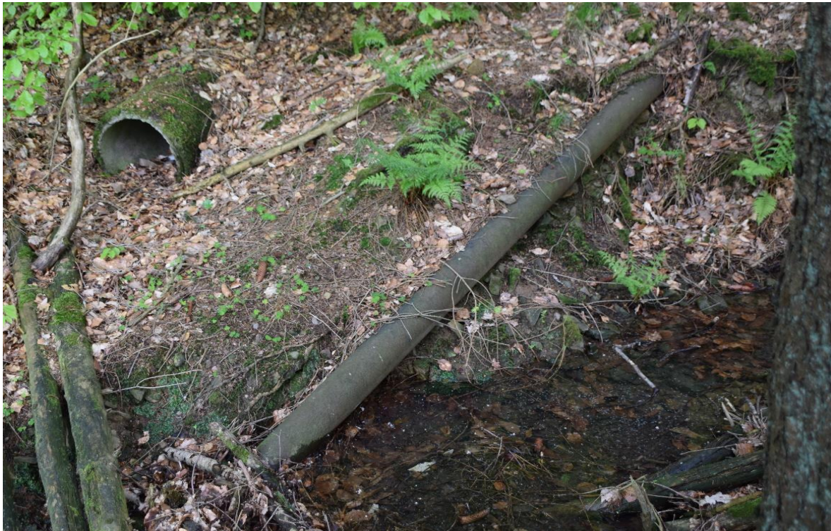
Gussrohr aus der Rhonard zur ehemaligen Wasserversorgung von Olpe am Wasserbehälter
