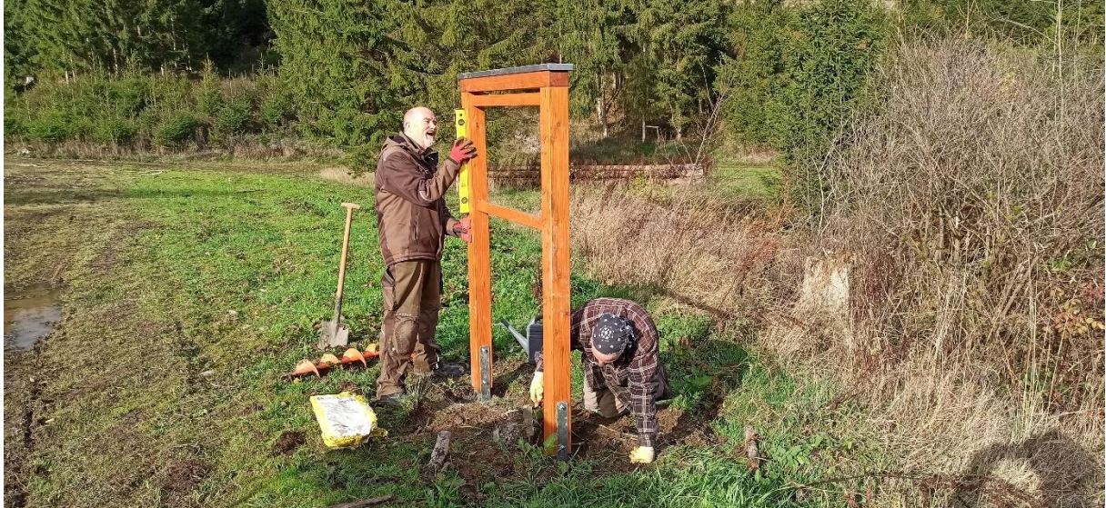
Aufstellen der Kandelaber im Maasmicketal
