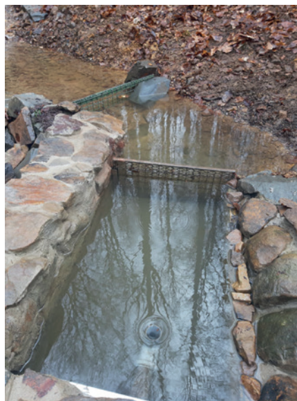
befestigter Kump mit Laubfanggittern
